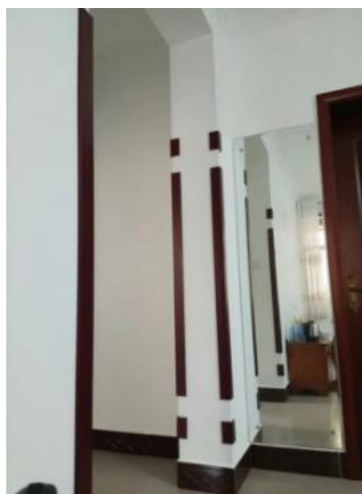
图 13 防撞条安装效果示意
