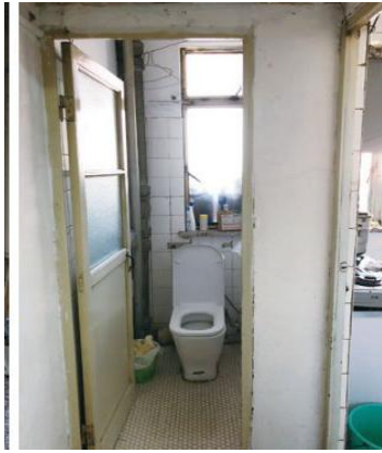
图 15 卫生间向外平开门或推拉门改造方法及效果示意
