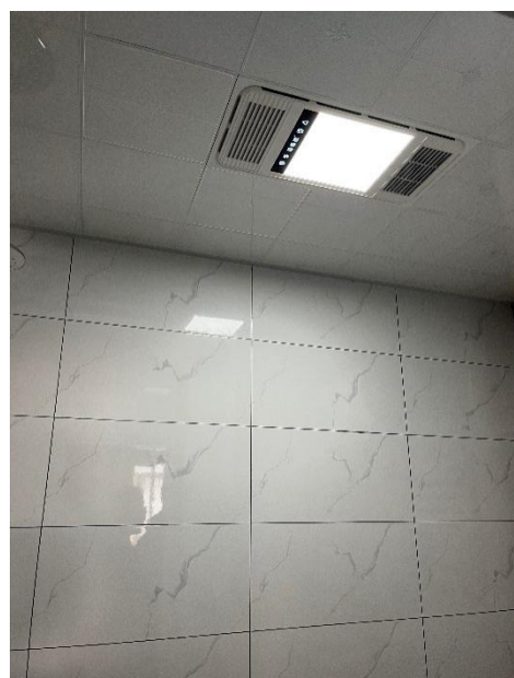
图 46 三合一暖风机安装做法及效果示意
