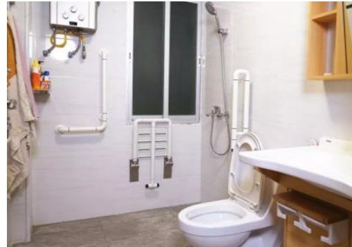
图 38 坐便器改造方法及效果示意
